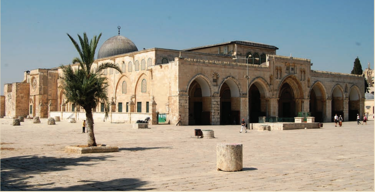
المسجد الأقصى المبارك - القدس الشريف
