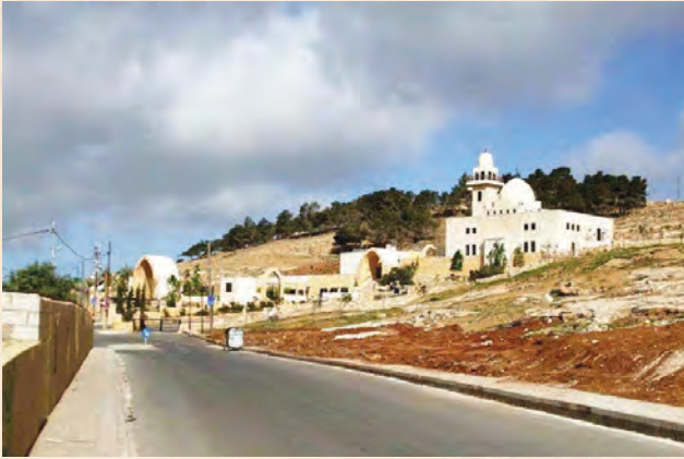
مسجد «كهف الرجيب» بعد إعادة بنائه
